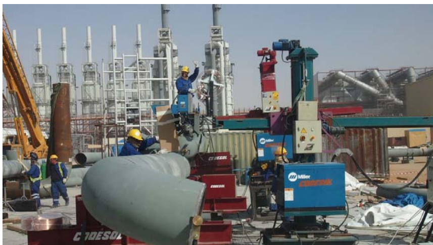
Layout en Obra
