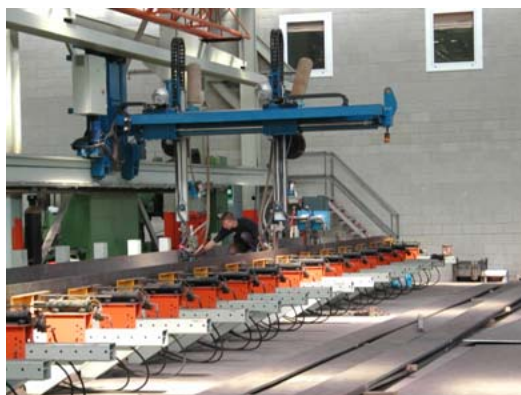
"H" ENSAMBLAJE Y SOLDADURA
